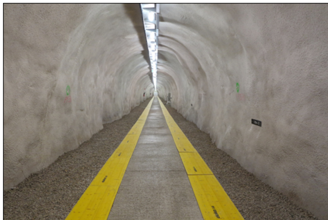
Abb.7: Die Gesamtlänge der Tunnel Anlage des GMO beträgt 1.016 m, die mittlere Überdeckung ist 25 m
