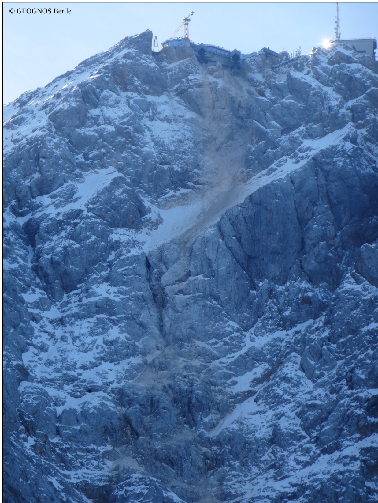
Baustelle Bergstation Nordseite
