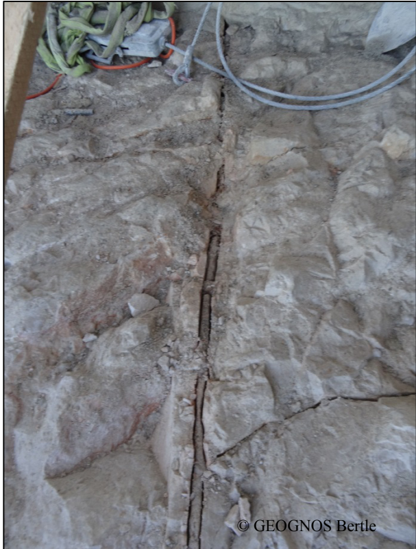
Aufstandsfläche Poller OST, Kluft mit Permafrosteis
