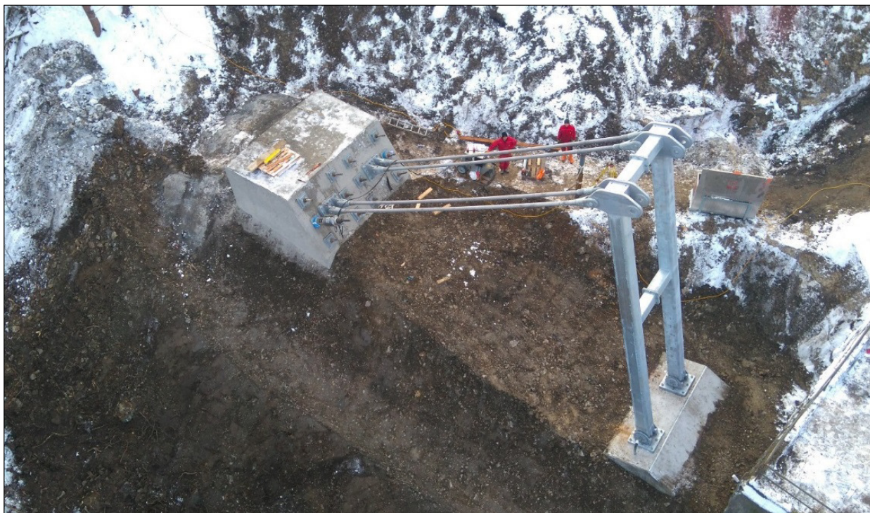
Abb.6: Fertige Widerlagerkonstruktion einer Hängebrücke mit Pylon und Zugstangen
