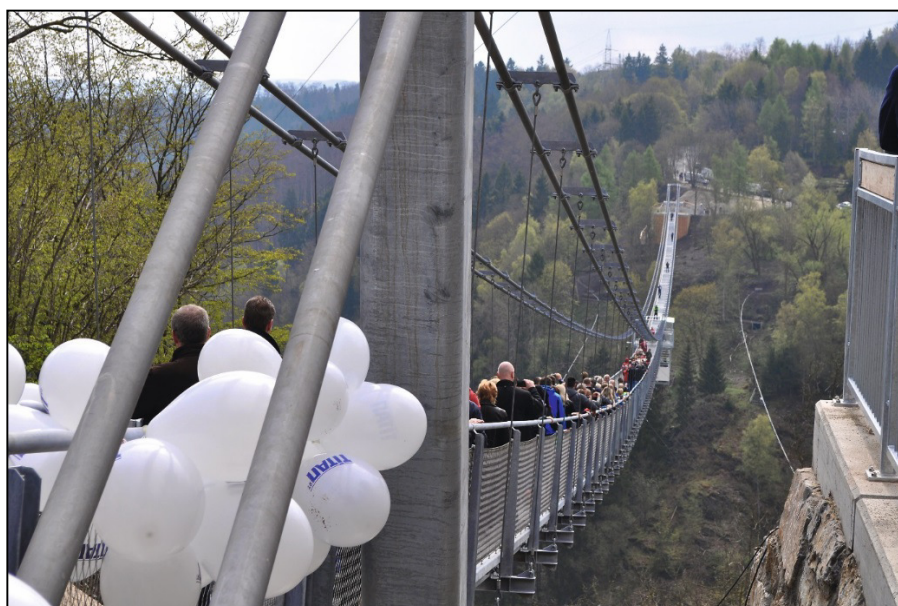
Abb.9: Besucheransturm bei der Hängebrücke Rappodetalsperre
