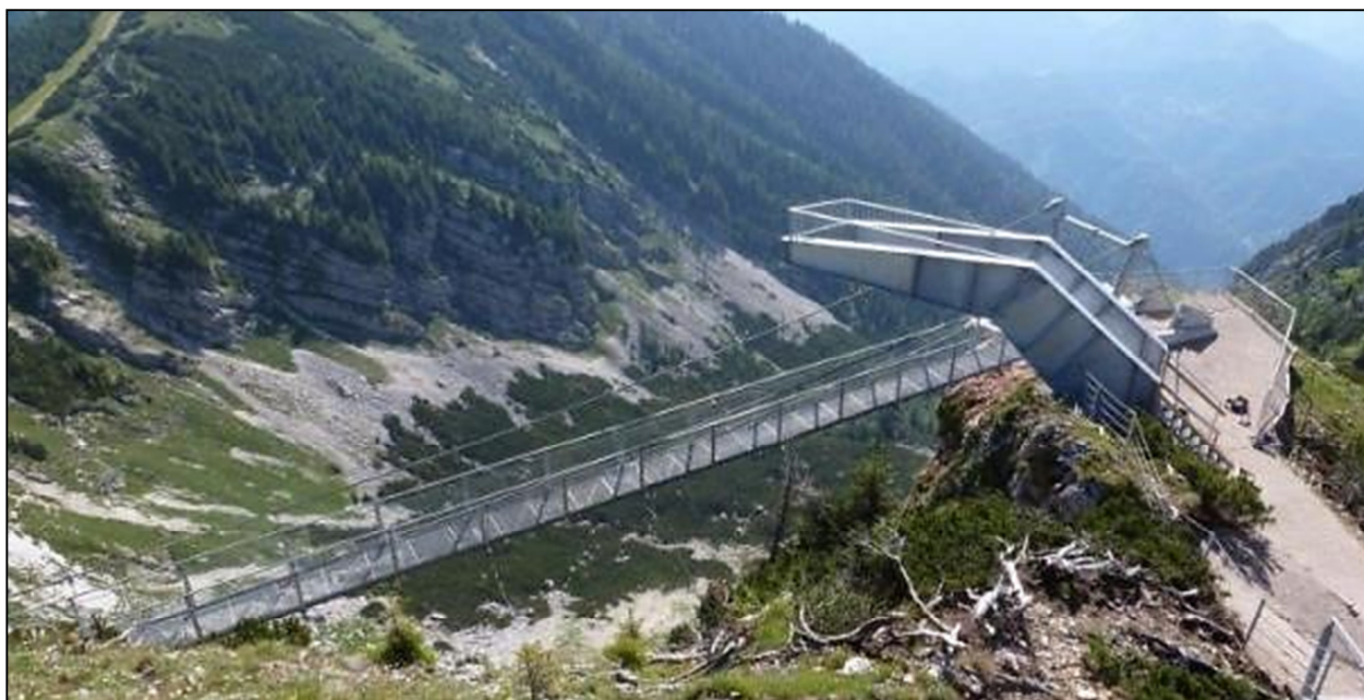
Abb.11: Aussichtsplattform und Hängebrücke Hochkar
