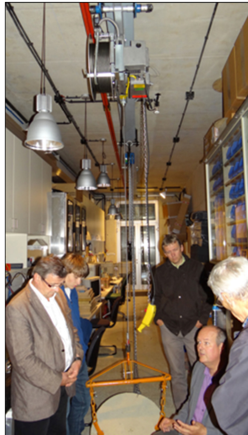
Abb.11: SGO - Instrumenten Tunnel mit einem GPS Wiederausstrahlungssystem plus Versorgungsleitungen für Strom und Datenverbindungen
