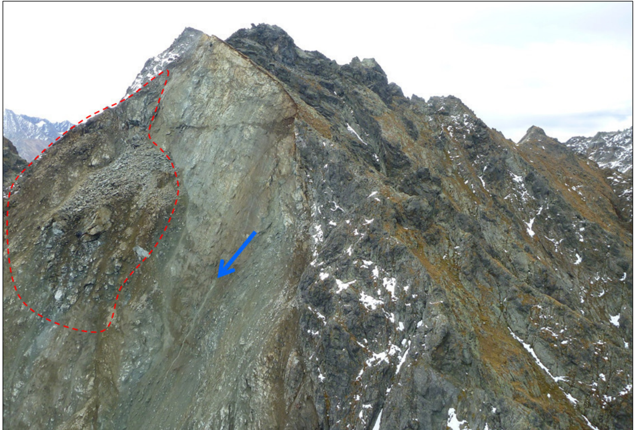
Abb. 5: Rot eingekreist = Felsgrat mit lose lagerndem Blockmaterial; Blauer Pfeil = Wasseraustritte auf Trennfläche
