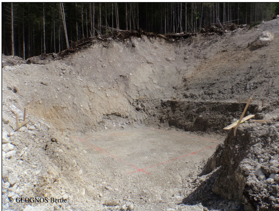
Aufstandsfläche Fundament Stütze 1
