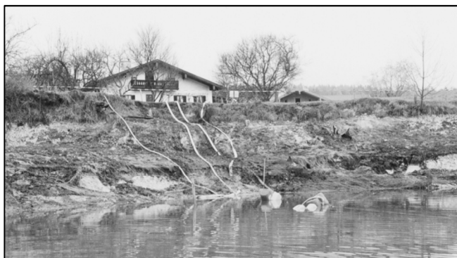
Abb. 7: Grögern Weiher beim Pumpversuch um 3,6 m abgesenkt (02.11.99)
