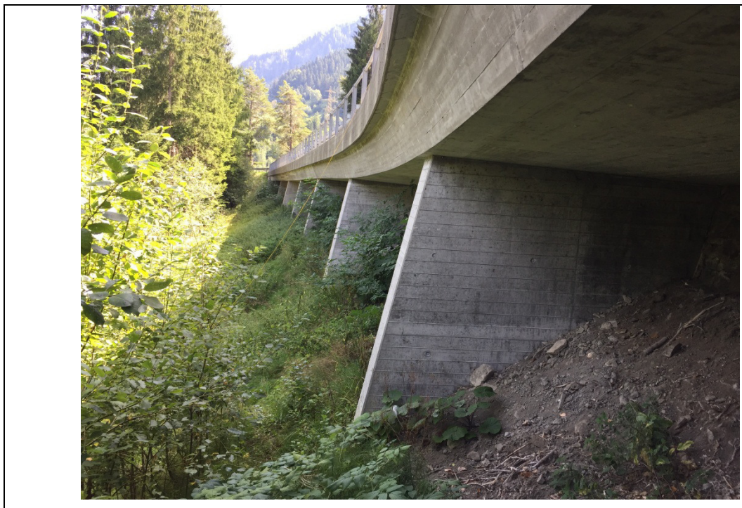
Abb. 5: Die seismischen Profile konnten im Bereich der Lehnenbrücke ohne grössere Unterbrücke installiert werden.
