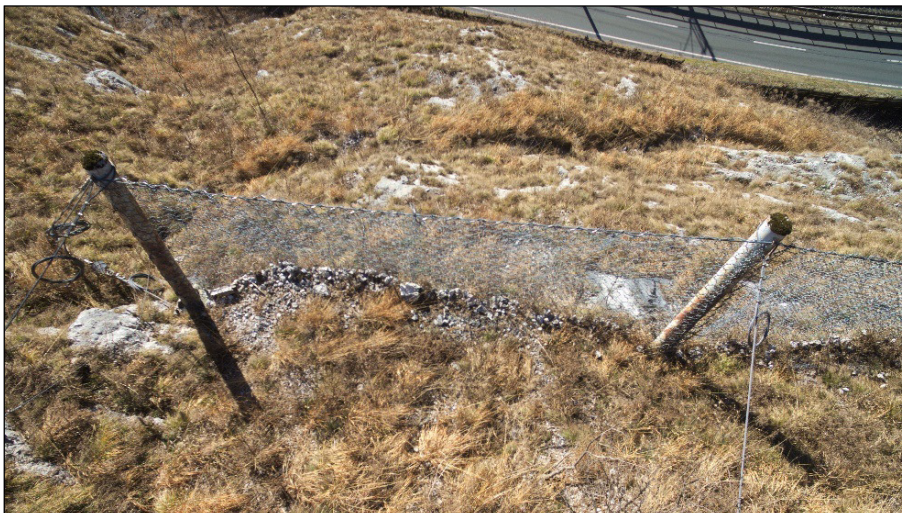
Abb. 4: Luftbild eines Steinschlagschutznetzes (direkte Befliegung)
