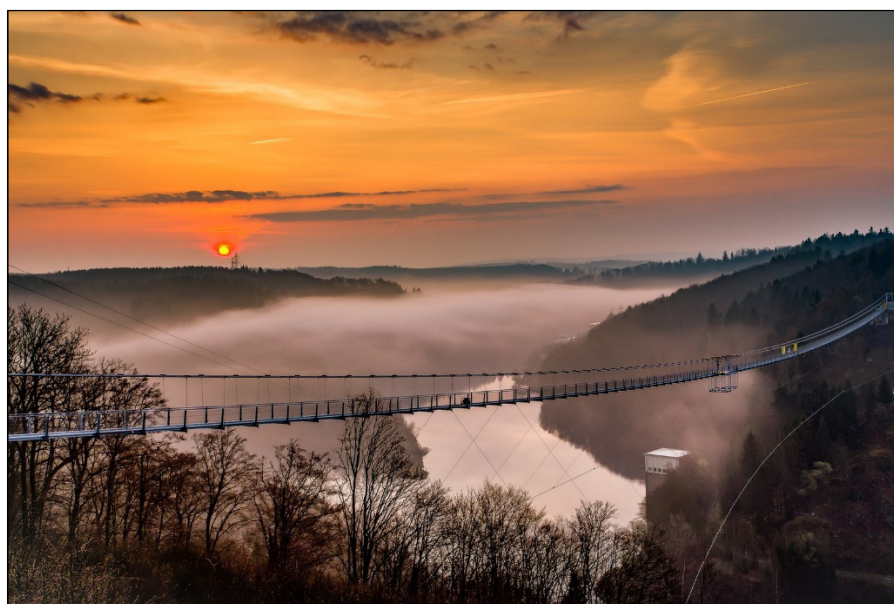
Abb.8: Hängebrücke Rappodetalsperre in der Dämmerung
