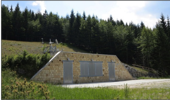
Abb.10: CONRAD Observatorium – Baustufe 1, Westportal. SGO – Seismik Gravimetrie Observatorium, 1998 Stollenanschlag – 2002 Eröffnung
