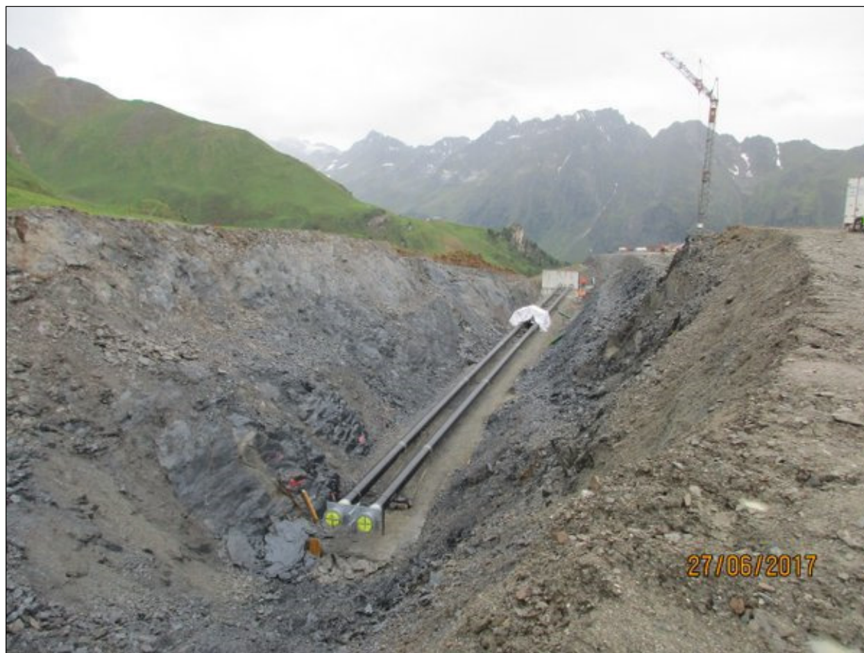
Abb. 6: Entnahmegraben von Entnahmebauwerk zu Vorpumpstation
