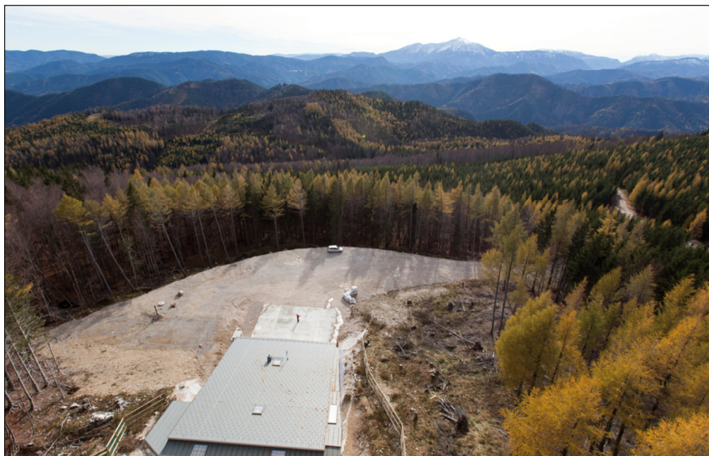
Abb.13: CONRAD Observatorium – Baustufe 2, Südportal mit Blick zum Schneeberg.
